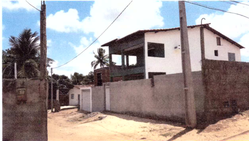
Figura 12. Lado Oeste - Loteamento Bosque do Rio
