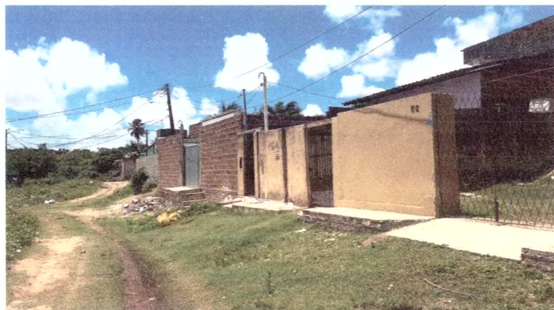
Figura 13. Lado Oeste - Loteamento Bosque do Rio
