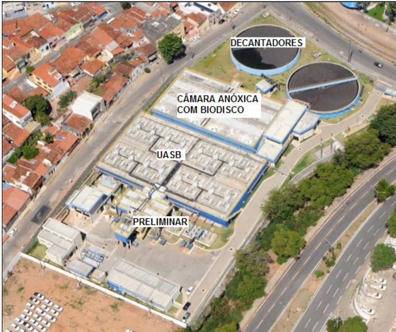
✓ Planta da ETE do Baldo.
