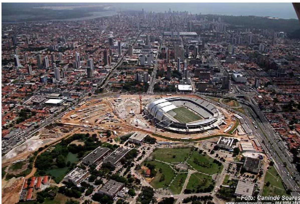
Figura 24 – Vista aérea de Natal. No primeiro plano o Centro Administrativo (Poder Executivo Estadual) e a Arena das Dunas – estádio de futebol e complexo multiuso em fase de construção para a Copa do Mundo de futebol de 2014 – ambos localizados em Lagoa Nova. Do lado esquerdo, margeando o estádio e o Centro Administrativo, a Avenida Prudente de Moraes. Do outro lado, também, margeando os dois complexos, a Avenida Salgado Filho. No segundo plano, o processo de verticalização nos bairros de Lagoa Nova, Tirol, Lagoa Seca, Petrópolis, Barro Vermelho e Areia Preta. 2013.
