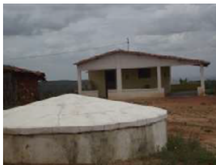
Figura 159 - Casa Nova, casa antiga e cisterna de placas
