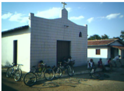
Figura 14 – Capela da Cajazeiras
