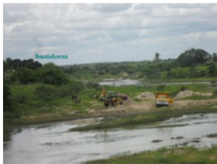
Figura 50 - Paisagem do Rio Curimataú (retirada de areia das margens)
