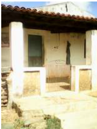
Figura 160 - Casa de alvenaria abandonada
