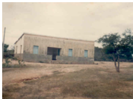
Figura 136 - Escola da Boa Vista (atualmente desativada)
