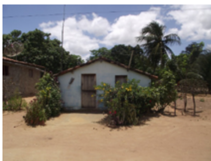
Figura 61 - Casa de taipa
