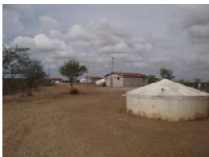
Figura 151 - Casas de alvenaria com cisterna de placas
