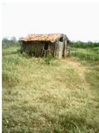
Figura 162 - Casa de taipa abandonada
