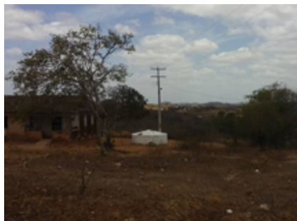
Figura 118 - Linhas de energia de alta tensão na comunidade
