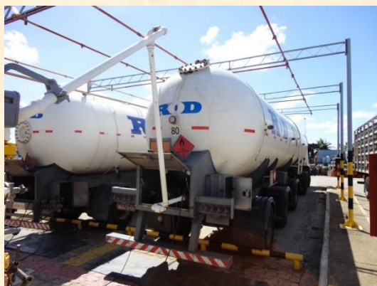
Figura 8 – Recebimento de GLP por tubulação.
