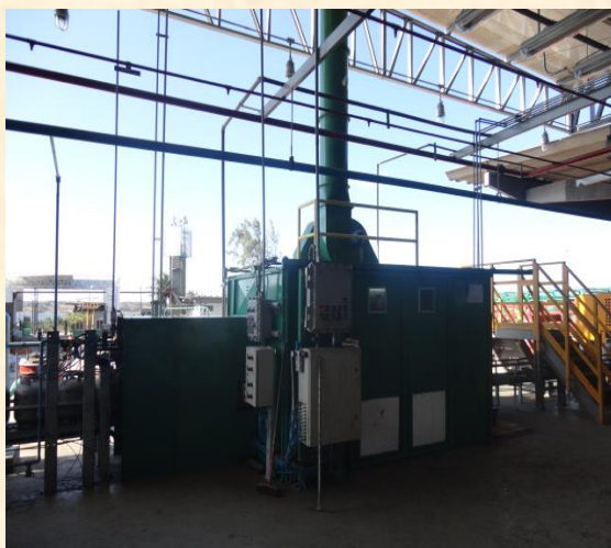
Figura 32 – Dimensão da cabine de pintura.
