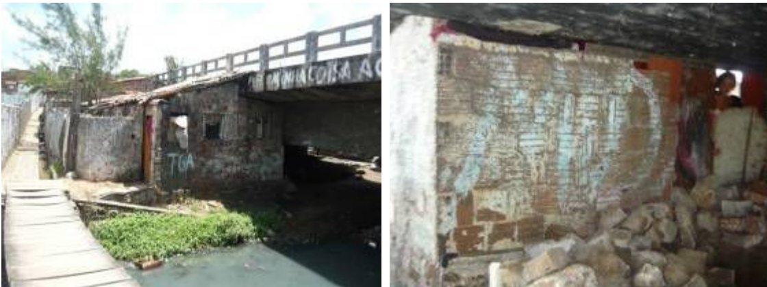
Figura 44: Moradias localizadas sob o viaduto. Fonte: Idesplan.
