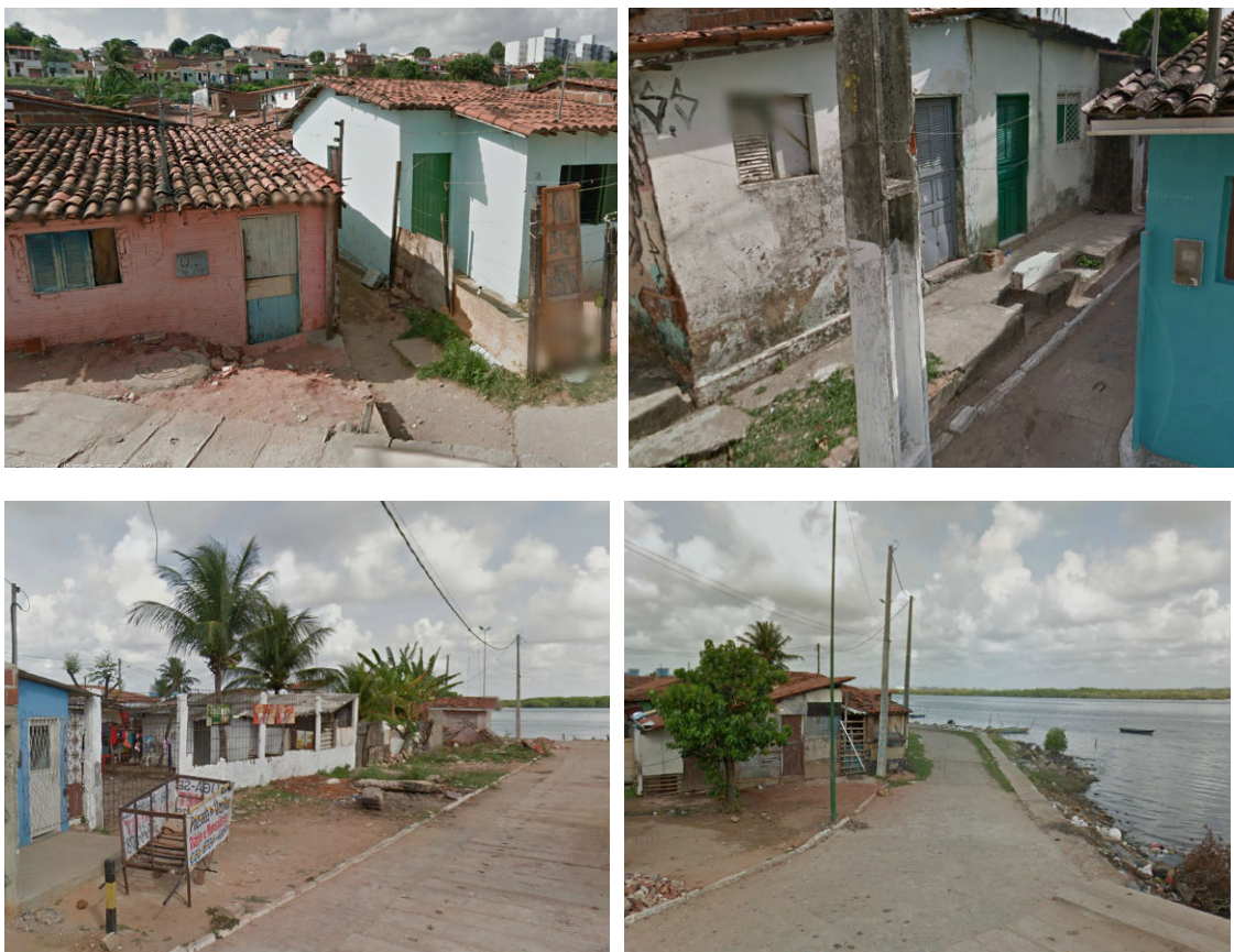
Figura 246: Setor precário do assentamento. Fonte: Google Street View.
