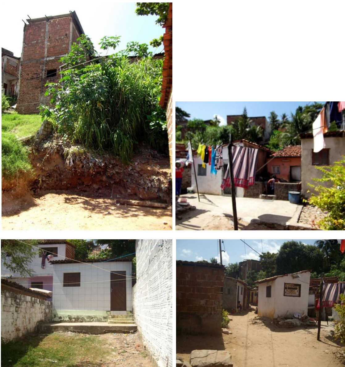
Figura 193: Fotos expõem o padrão construtivo das unidades do assentamento do Jacó. Fonte: Idesplan.
