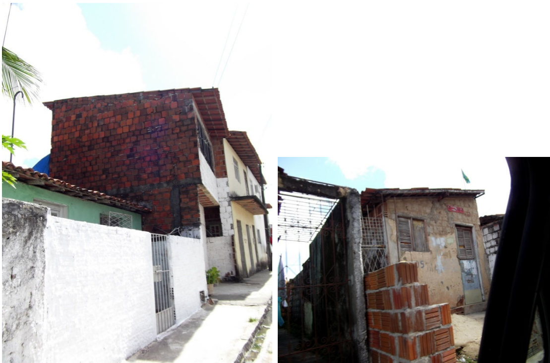
Figura 348: Exemplos de edificações com um e dois pavimentos.Fonte: IDESPPLAN
