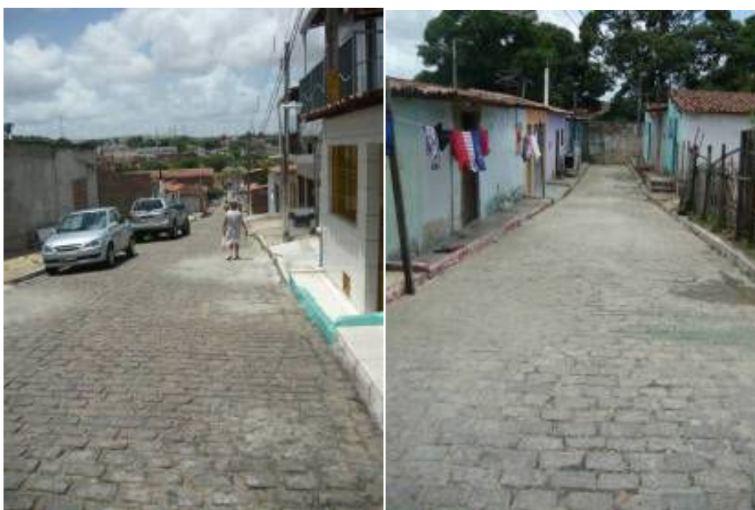
Figura 42: Área pavimentada, localizada na entrada da favela. Fonte: Idesplan.
