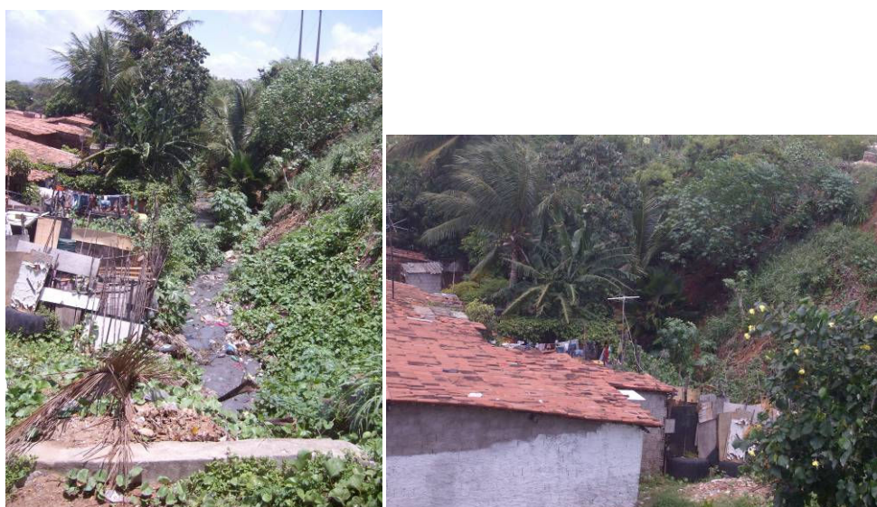
Figura 37: Moradias localizadas margeando o córrego, com alagamento freqüente e risco de queda de barreira. Fonte: Idesplan.
