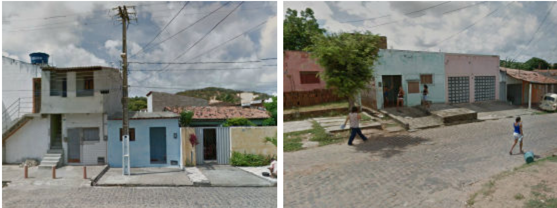
Figura 138:Características habitacionais do conjunto.Fonte: Google Street View.
