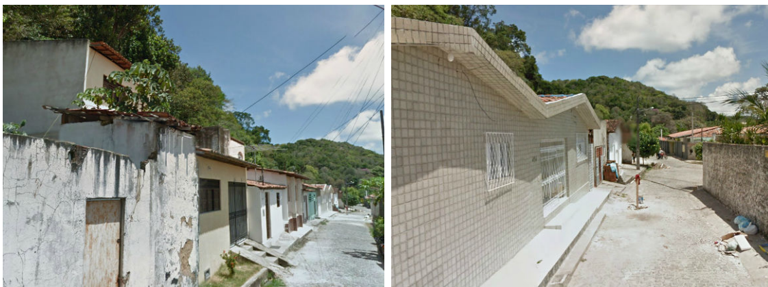
Figura 355: Exemplos de edificações com bom padrão habitacional. Fonte: IDESPPLAN 2011
