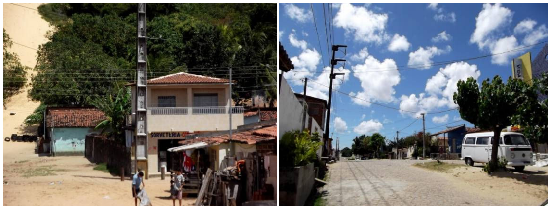
Figura 131: Abastecimento de infraestrutura. Favela do Alemão. Fonte: Idesplan.
