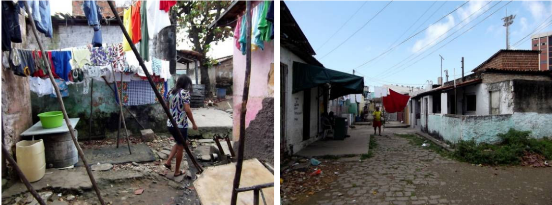
Figura 198: Tipologia das edificações da comunidade do Maruim. Fonte:Idesplan.
