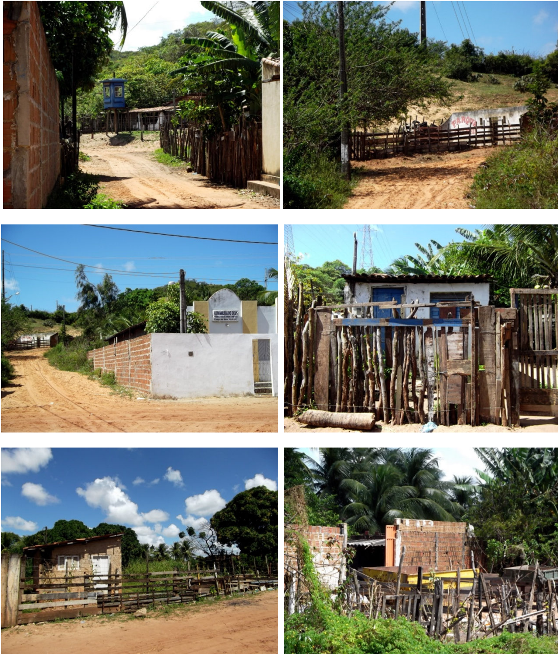
Figura 168: Ruas sem pavimentação. Práticas rurais. Acúmulo de resíduos. Padrão das edificações. Acúmulo de entulho em terreno. Fonte: Idesplan.
