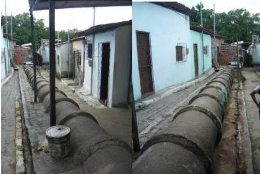
Figura 43: Área pavimentada com tubulação de esgoto aparente. Fonte: Idesplan.
