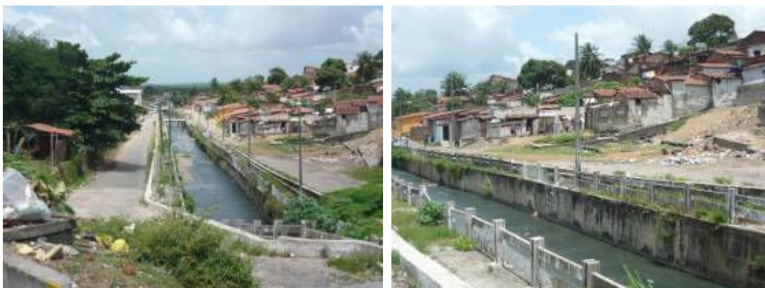
Figura 24: Vista do canal que passa na comunidade.
