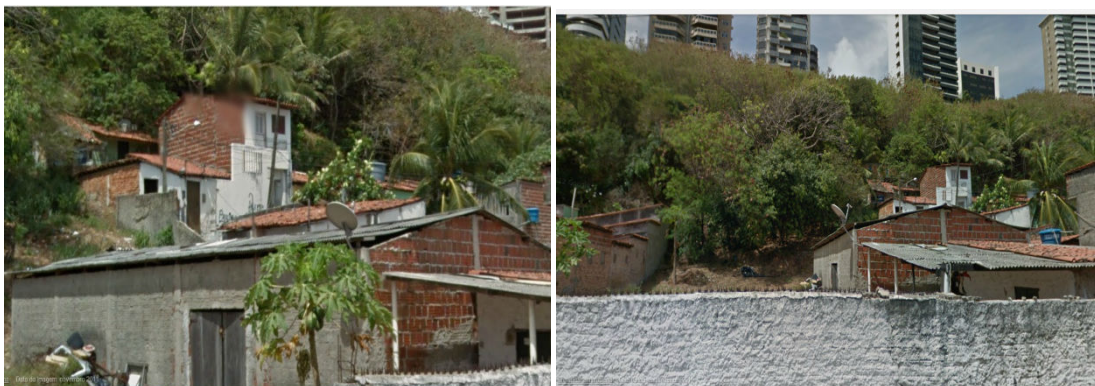
Figura 211: Casas localizadas em área de risco.Fonte: Google Street View.
