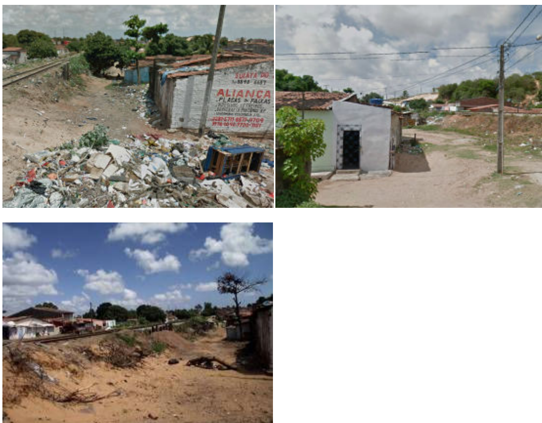
Figura 153: Rua do assentamento Urubu localizada em área de domínio da ferrovia. Fonte: Idesplan.
