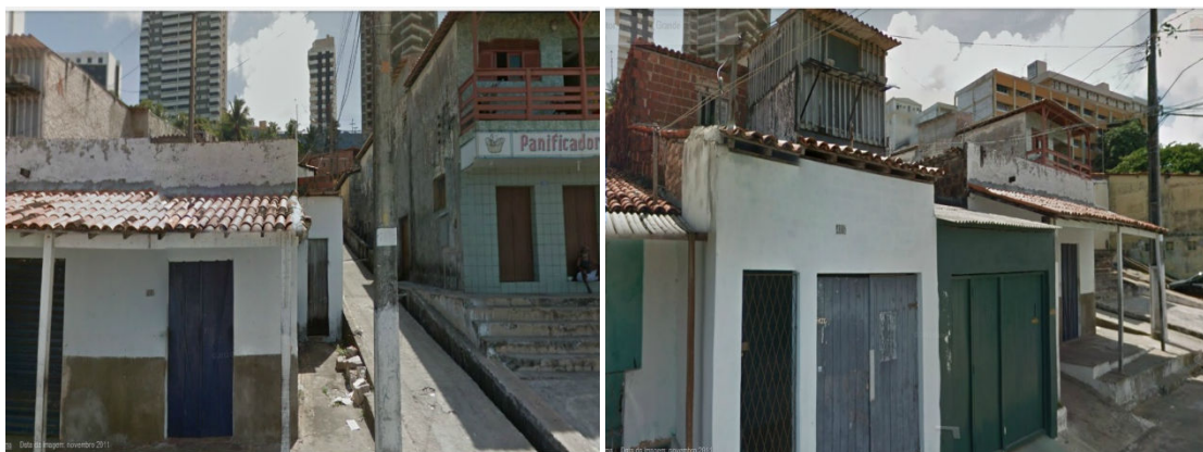
Figura 213: Casas situadas em vielas. Fonte: Google Street View
