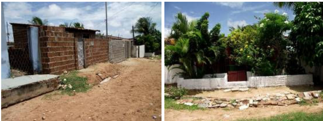
Figura 310: Barreiras construídas pelos moradores para impedir o alagamento de suas casas. Fonte: Idesplan.
