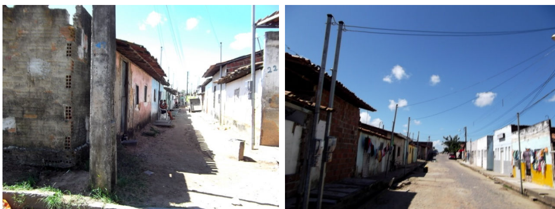
Figura 98: Águas pluviais e esgotos despejados diretamente nas vias, não contempladas pela urbanização. Fonte: Idesplan.
