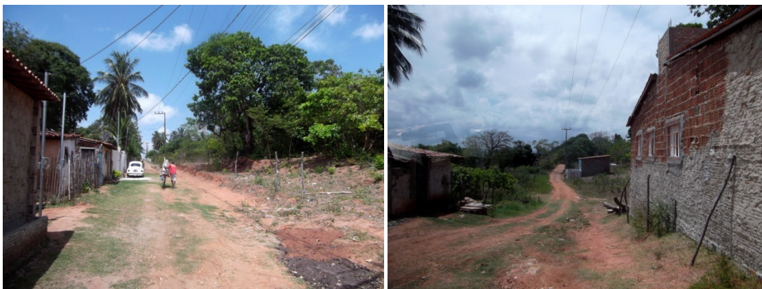
Figura 291: Ruas sem infraestrutura.
