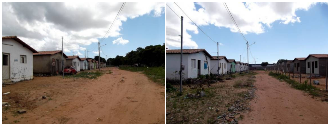
Figura 90: Fotos das moradias em processo de construção da Comunidade Wilma Maia. Fonte: Idesplan.
