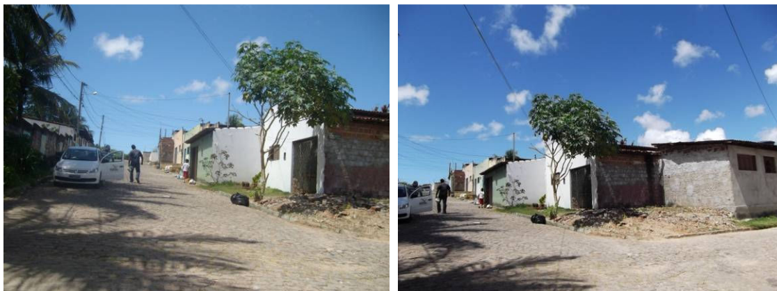
Figura 109: Vias pavimentadas no assentamento lavadeiras. Fonte: Idesplan.
