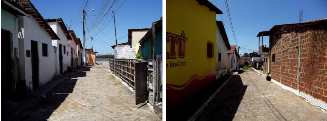
Figura 263: edificações construídas em alvenaria. Comunidade Beira Rio. Fonte: Idesplan.
