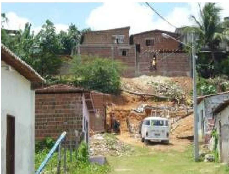
Figura 28: Deslizamento de barreira ocorrido no dia da visita e com queda de árvore.
