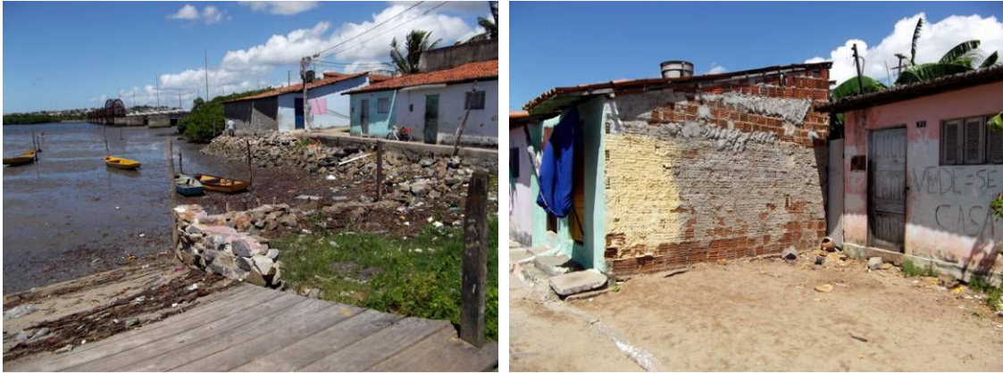
Figura 269: drenagem das águas pluviais e esgotos despejados no Rio Potengi.
