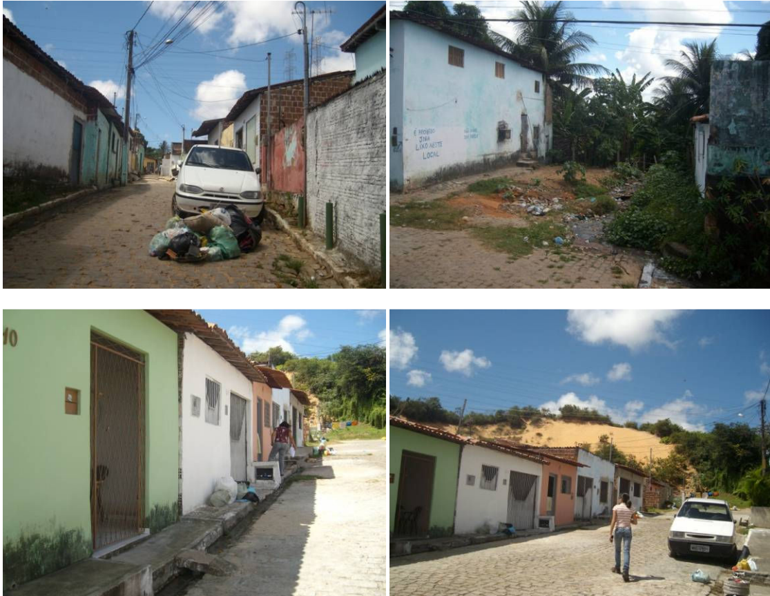
Figura 115: Áreas com acúmulo de resíduos e abastecimento de infraestrutura. Fonte: Idesplan.
