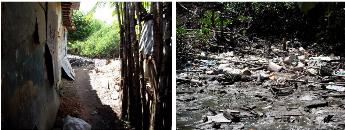
Figura 85: drenagem das águas pluviais e esgotos despejados no Estuário do Rio Potengi. Fonte: Idesplan.
