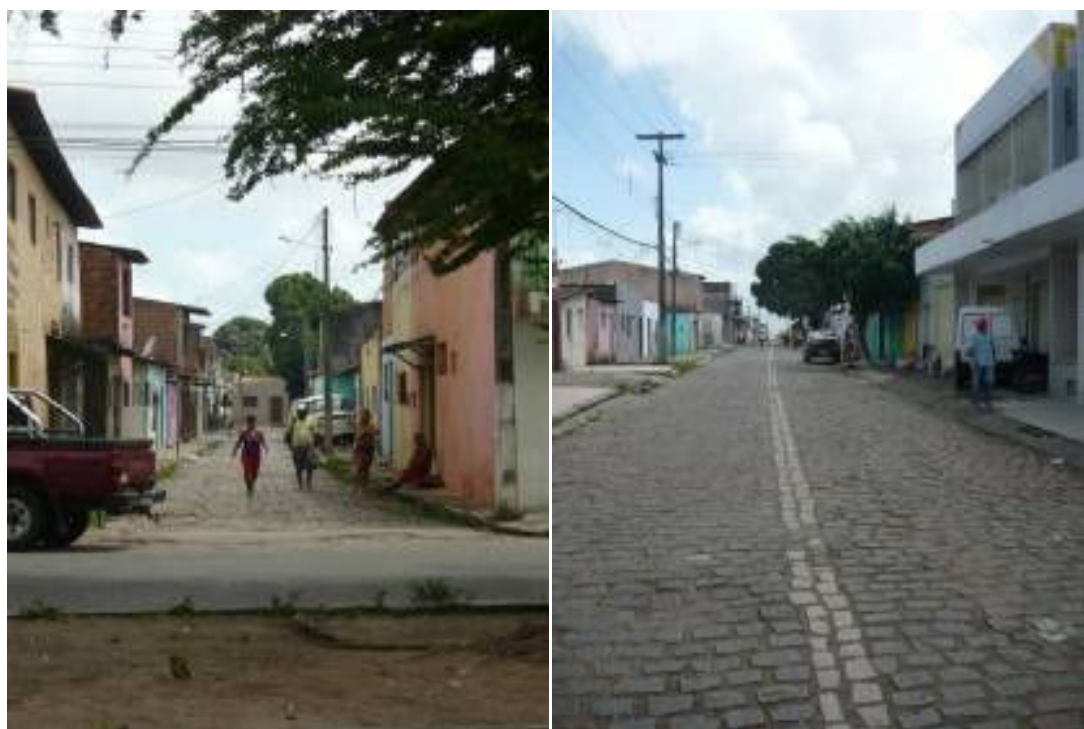
Figura 64: Vistas de ruas do Mereto onde se observa a urbanização da área. Fonte: Idesplan.
