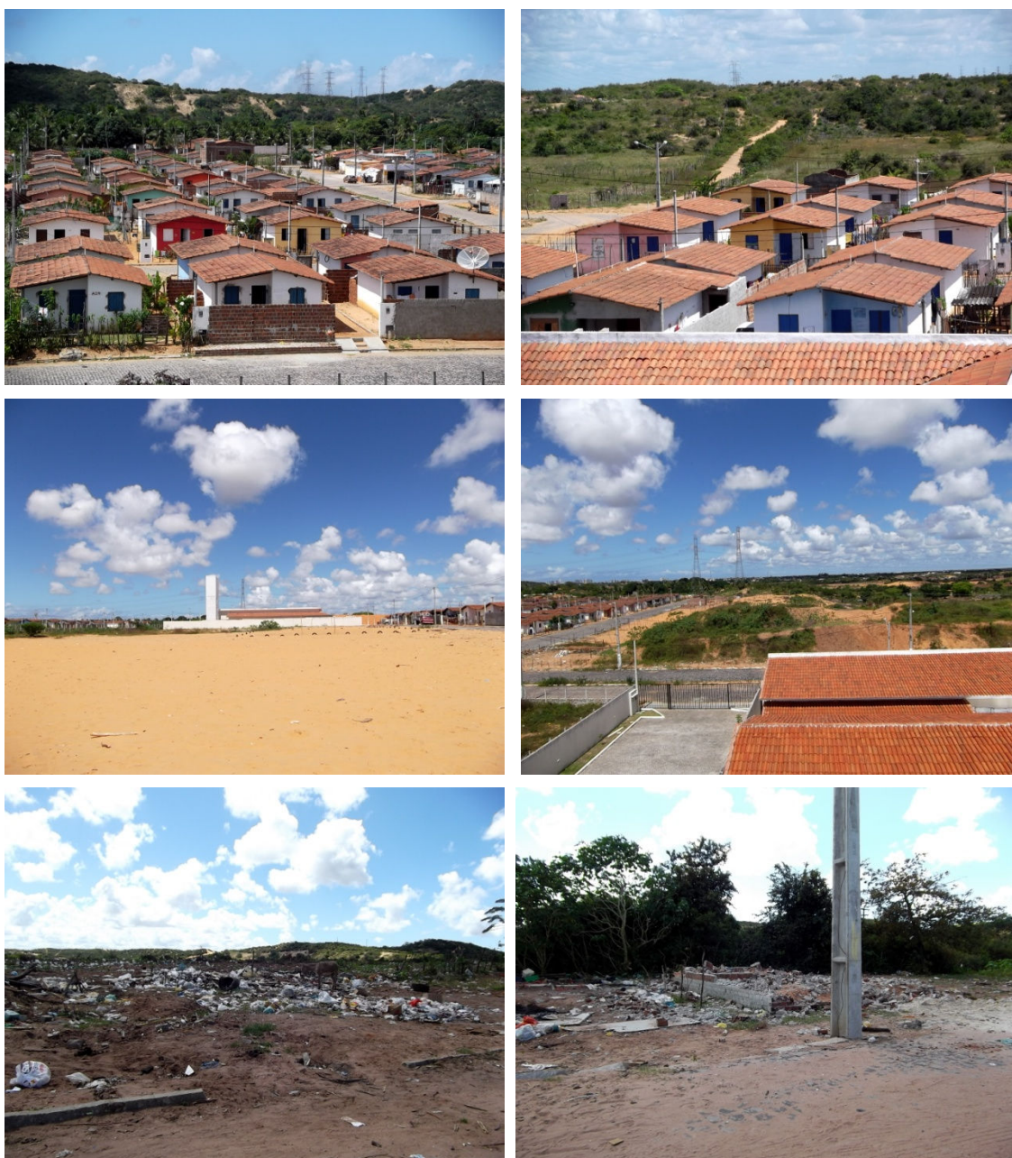
Figura 157: Fotos do assentamento. Ocupação em áreas de duna e sob rede de alta tensão. Acúmulo de resíduos. Fonte: Idesplan.
