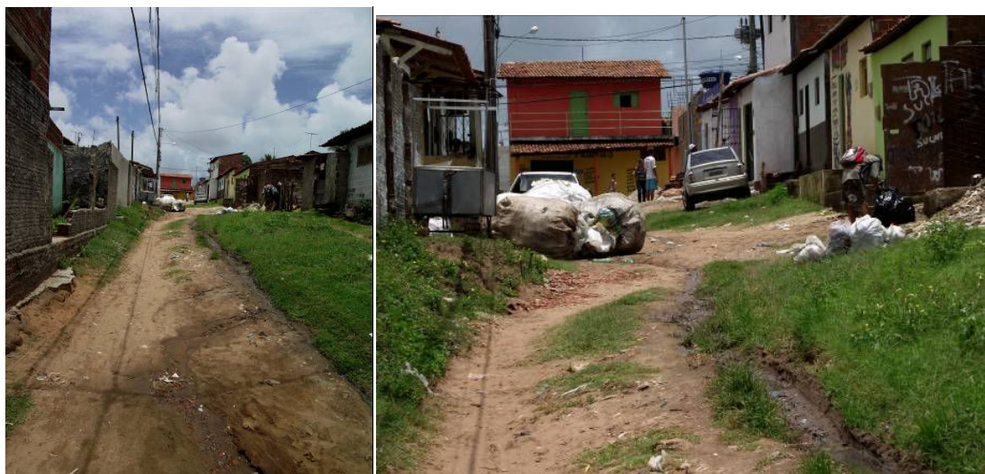
Figura 317: As vias principais são pavimentadas e apresentam boa infraestrutura, entretanto, as vias no interior das quadras estão bastante degradadas, assim como em Raio do Sol. Fonte: Idesplan.
