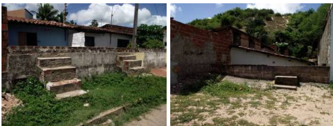
Figura 147: Casas com muro de contenção contra enchentes. Fonte: Idesplan.
