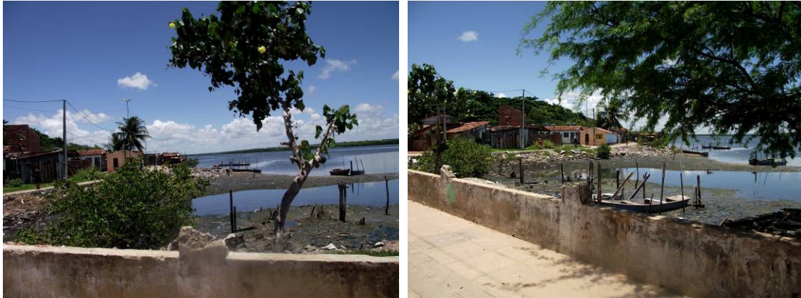
Figura 223: Muro de contenção. Fonte: Idesplan
