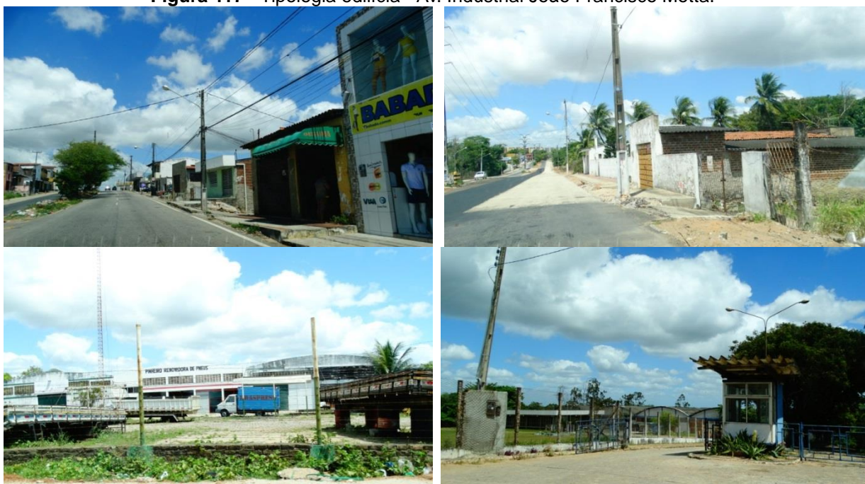
Figura 117 - Tipologia edilícia - Av. Industrial João Francisco Motta.
