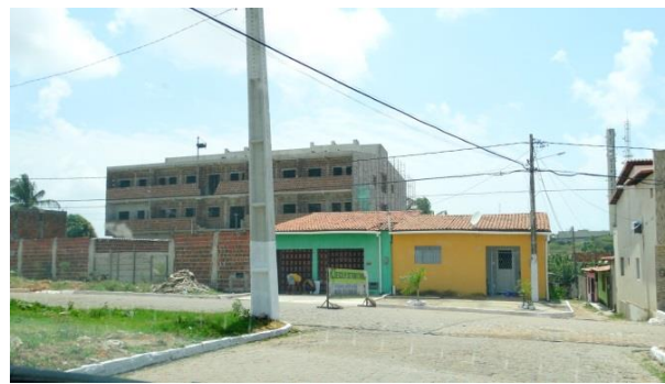
Residencial unifamiliar e Residencial multifamiliar. Vista da Rua Dr. Augusto Cesino Monteiro Medeiros a partir da Rua Urtigueira. Gabarito pontual de três pavimentos
