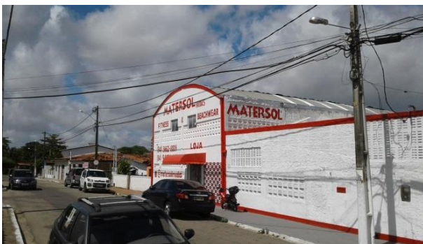
Usos industrial – fábrica de roupas de banho. Gabarito dois pavimentos tipo galpão. Conjunto Potengi.
