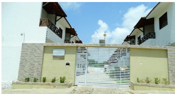
Condomínio Horizontal Villas do Potengi Residence - Rua Construtor Severino Bezerra.
