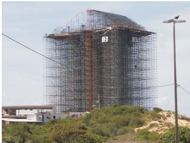
Foto 01: Construção da Torre. Fonte: arquivo SEMURB
