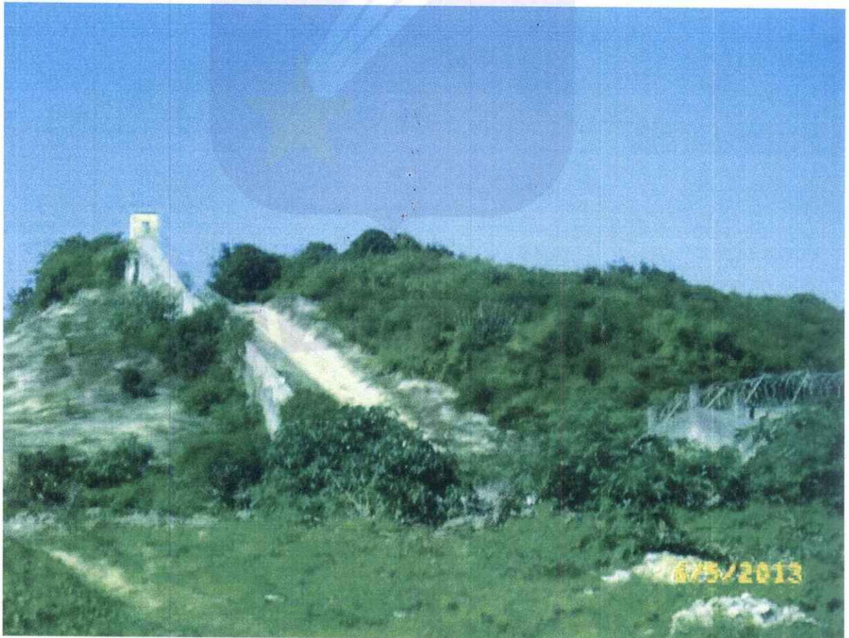
Foto 09 e 10: Muro que divide e delimita a Barreira contribuindo para a conservação.
