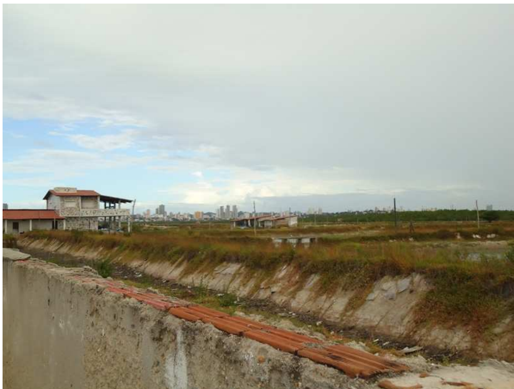
Ilustração 32: Obras de manutenção nos viveiros. Arquivo IBAM;SEMURB, 2010.
