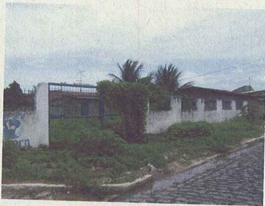
Figura 27 - Águas servidas na via Fonte: Aprove Consultoria, 2009.
