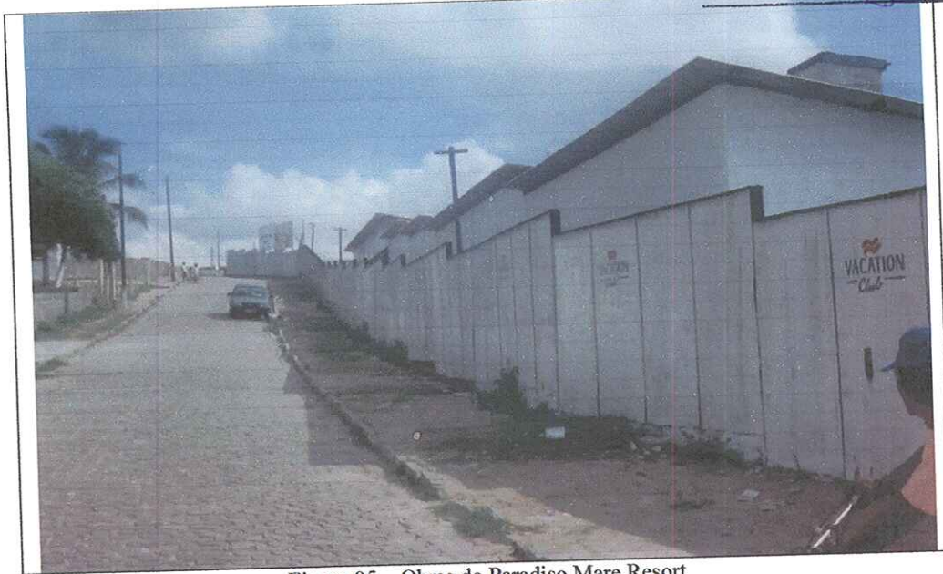
Figura 05 – Obras do Paradiso Mare Resort
