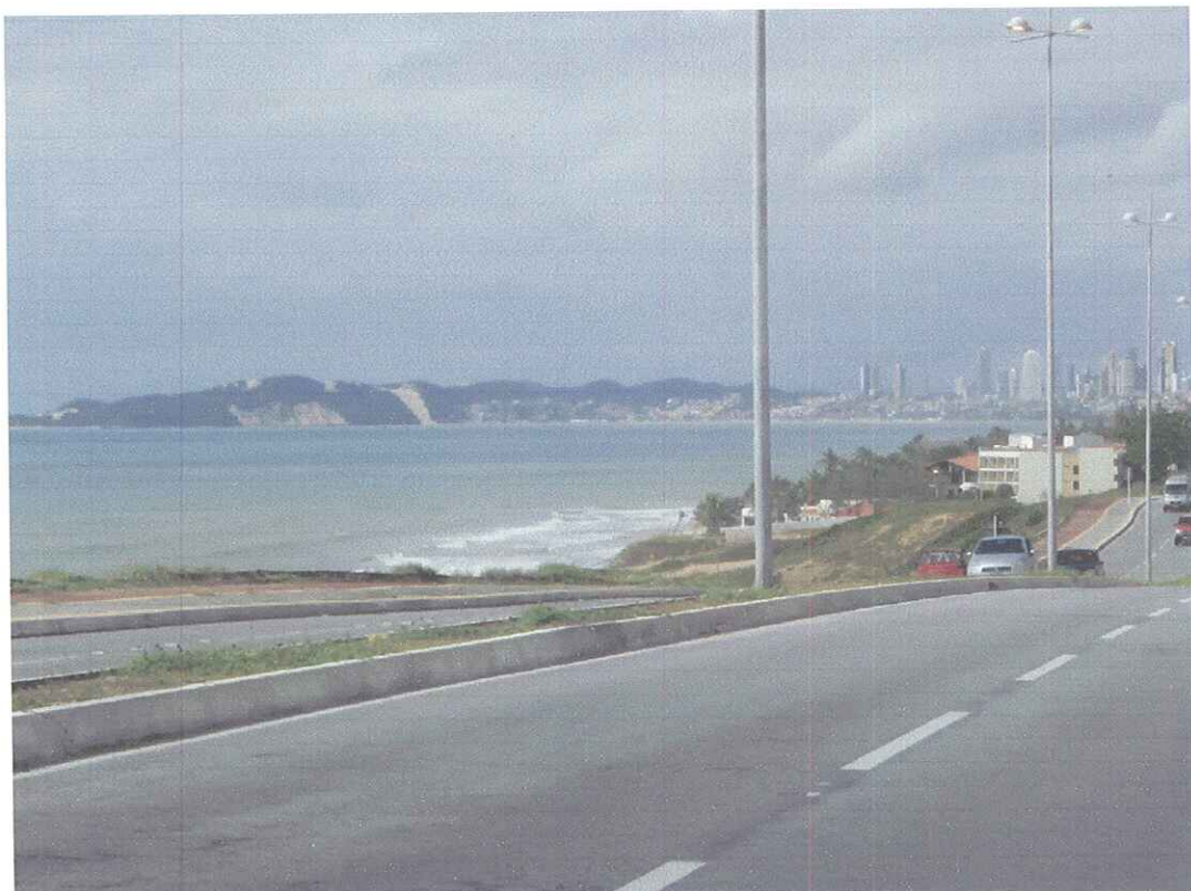
Figura 39 – Vista do Litoral Sul a partir da Via Costeira
