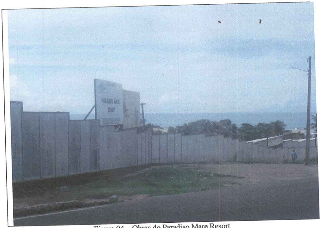
Figura 04 – Obras do Paradiso Mare Resort
