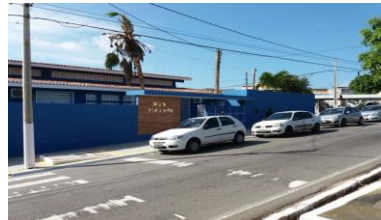
UBS PIRANGI - REFORMA CONCLUÍDA
