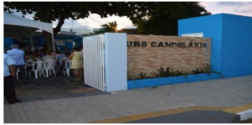
UBS CANDELÁRIA - CONCLUÍDA
