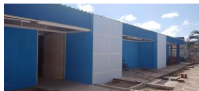
UBS QUINTAS - REFORMA CONCLUÍDA
