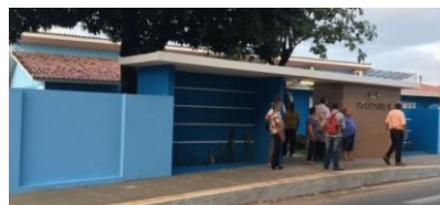
UBS SOLEDADE II - REFORMA CONCLUÍDA
